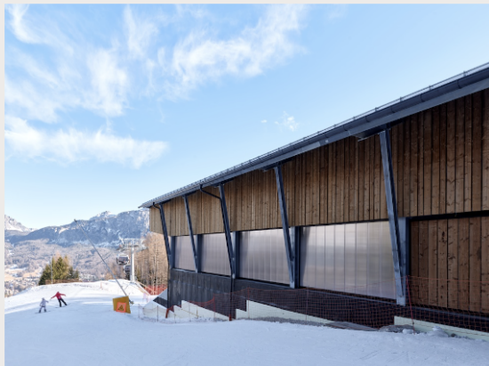
Nel progetto per le stazioni della cabinovia, le lastre di PanelPiù 500/60 14P sono affiancate alle superfici in legno volutamente lasciate grezze (foto: Federico Covre)
