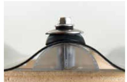
Dettaglio di fissaggio.
